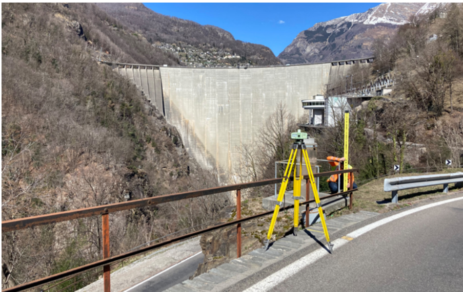
Bild 2: Präzisionsnivellement in der Nähe der Staumauer Contra (TI) (Bild: Schneider Ingenieure AG).
